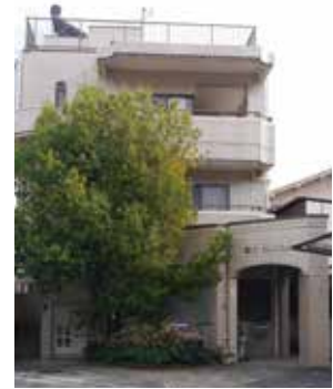
細川・内藤医院外観
